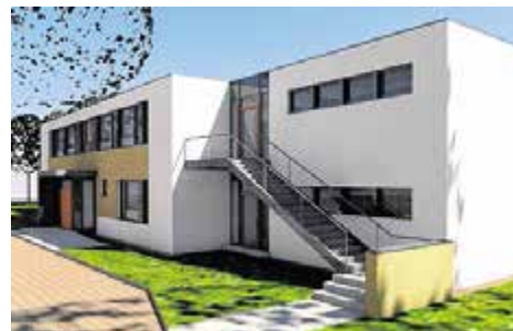
In dem zweigeschossigen Erweiterungsbau auf dem Schulhof soll Platz für acht neue Klassenräume sein.
