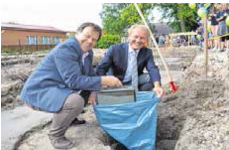
Schulleiter Wolfgang Rosenow (l.) und Sven T. Olsen versenken eine Zeitkapsel als Grundstein für den Neubau.
