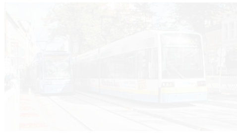
Vorsichtig fahren die Straßenbahnen durch den Baustellen-Bereich.
